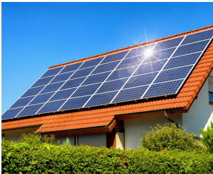
Dachparallele PV-Anlage
